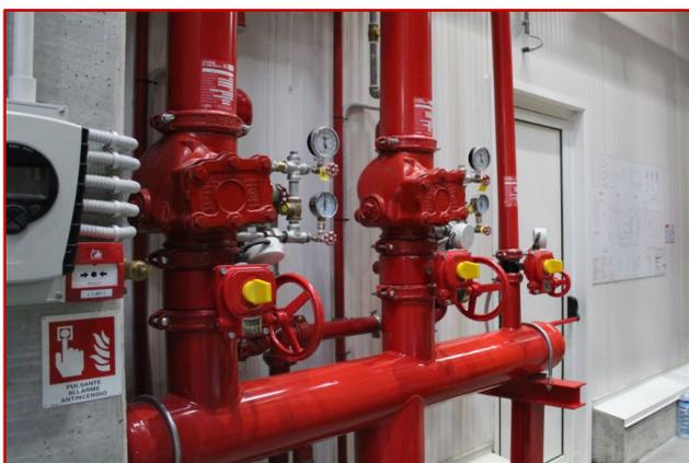
Oltre ai classici sistemi di automazione, Cassioli ha fornito a Sammontana anche un innovativo impianto antiincendio con relativa cisterna, con la riserva d'acqua, che lo alimenta: nello specifico, un impianto a sprinklers con rete idranti interna ed esterna, stazione di pompaggio e impianti di rilevazione fumi, secondo le normative vigenti.
